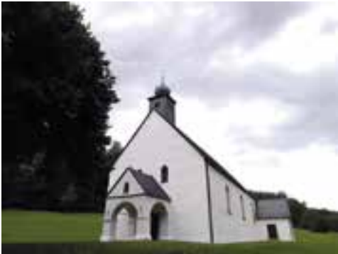
Wallfahrtskirche St. Jodok
